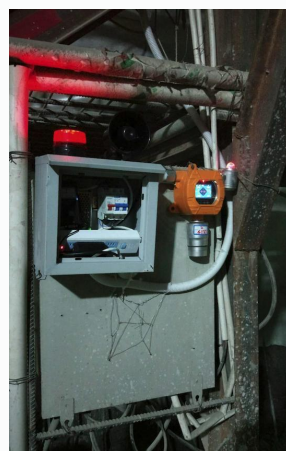
Мультигазовый детектор MIC600 В проекте NEOM в ОАЭ
